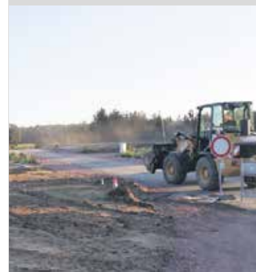
Die Erschließungsarbeiten für das neue Baugebiet sind am Laufen.
